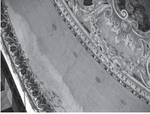
Resim 8. Süleymaniye Camii’deki rezonatörlerin kapatılmış ağızları, 2011 yılında tamamlanan onarımlardan önce. Kaynak: Yazarın fotoğrafı.
