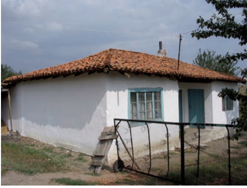
Şekil 3. Arizbaba Köyü'nde bir göçmen evi, 2005.
