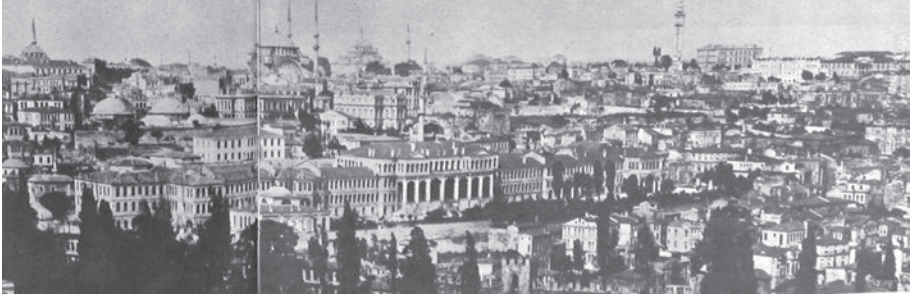
Şekil 7. Bâbüali deniz cephesinden görünüm (Eldem, 1979, 100-101)
