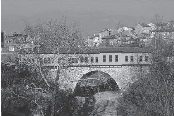
Resim 7. Irgandı Köprüsü, Bursa (KGMSBA).
