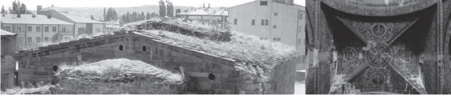
Resim 2. Tomarza Surp Boğos Bedros Kilisesi. Kubbe yapımı yasak olduğundan çatıpraz tonoz, çatının üzerinde hafifçe yükseltilerek vurgulanmıştır (Şeyda Güngör Açıkgöz).
