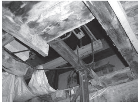
Resim 5. Tezgâhın işliğe sığdırılabilmesi için döşemenin kesilmesi, Buldan (Nezihat Köşklük Kaya).
