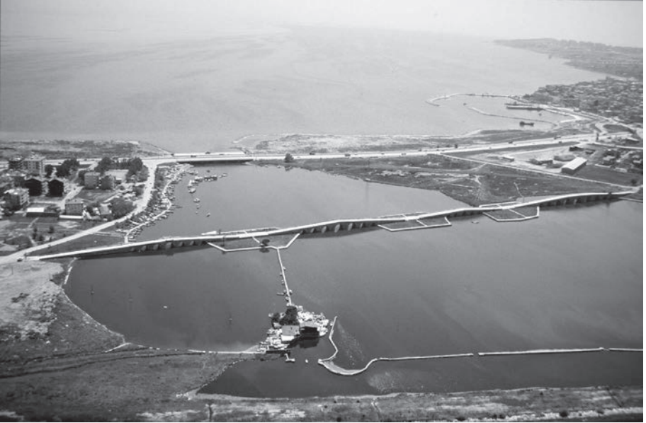
Resim 11. Büyükçekmece Köprüsü, İstanbul (KGMSBA).
