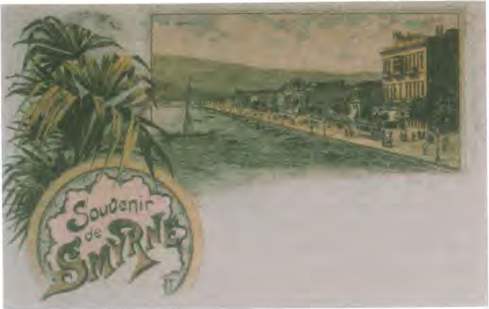
Resim 3- Eski bir kartpostalda Kraemer Palace Otel'i (sağda en yüksek bina).
